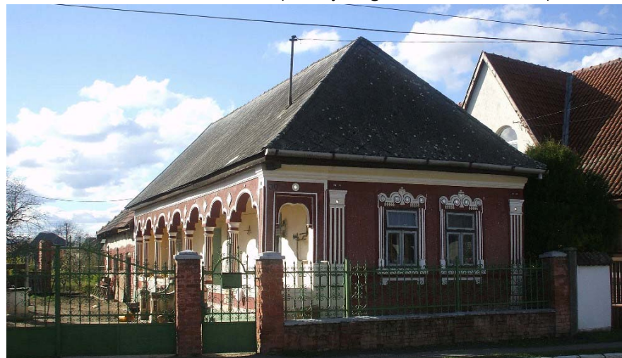
Szabadság út 30. A ruszin népi építészet jellegzetességeit példásan megőrző épület.
