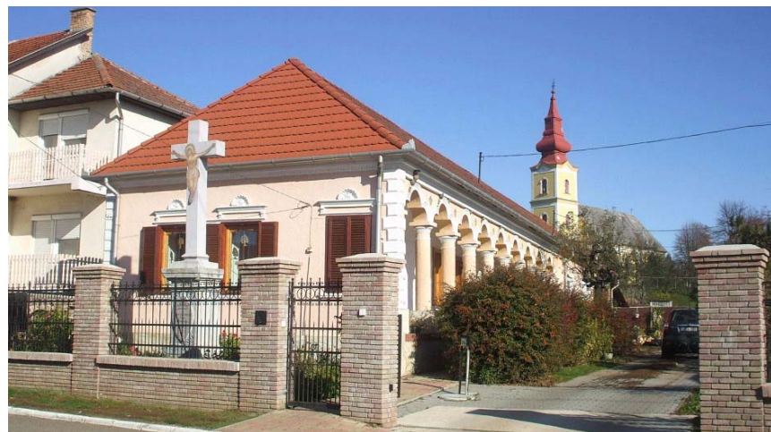
Szabadság út 47. Minta értékű felújítás. A tetőfedés, homlokzat-kezelés követésre méltó. A kerítés illeszkedik az épület jellegéhez és az utcaképhez.
