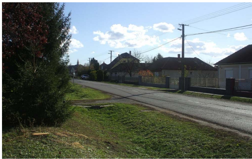
Az utak szilárd burkolattal rendelkeznek. A felszíni vízelvezetés az út menti árkokon keresztül történik, amelyeket a településen karbantartják.
