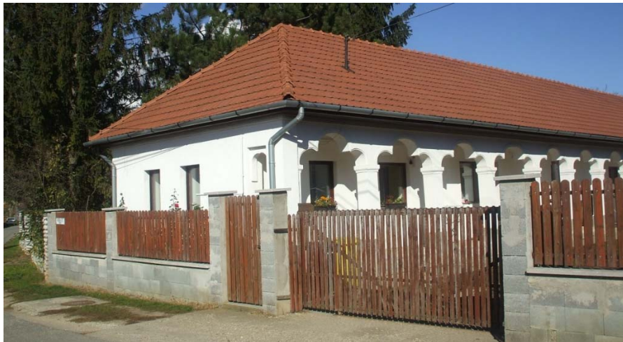
Dózsa György u. 5. Minta értékű felújítás. A tetőfedés, homlokzat-kezelés követésre méltó. A kerítés illeszkedik az épület jellegéhez és az utcaképhez.
